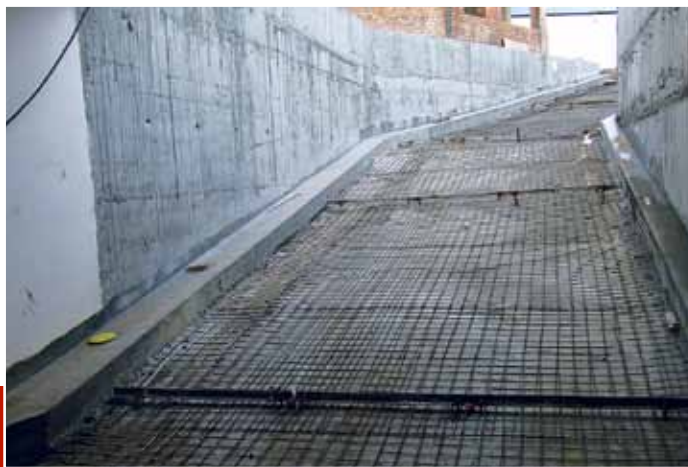
Монтаж системы «Теплотор» в заезде в гараж
