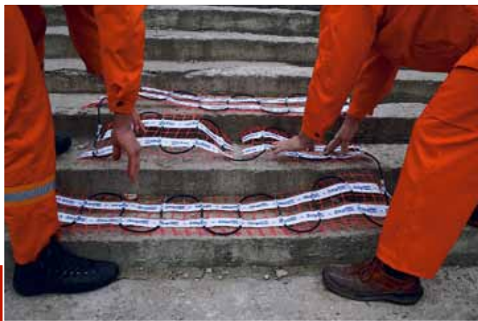
Монтаж антиобледенительных нагревательных матов Stoplice на ступеньках
